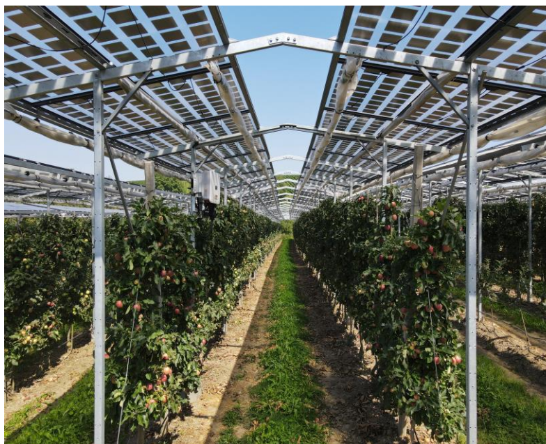
Hoch aufgeständerte Agri-PV-Anlage über Apfelbäumen. © Fraunhofer ISE
